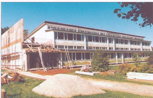
Gradnja vrtca pri OŠ Grad
