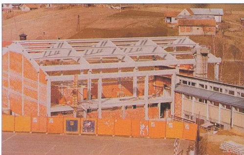
Gradnja telovadnice pri OŠ Grad.
