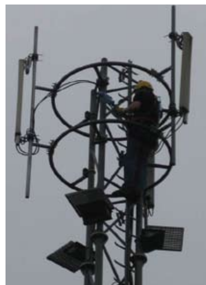
Slika 3: Delo na višini pred antenami baznih postaj
