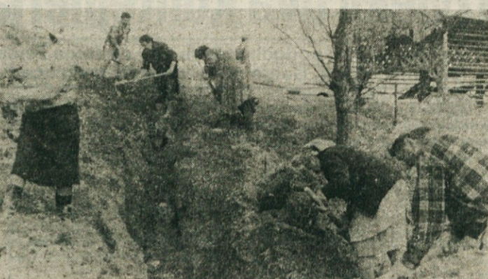
NOV VODOVOD ZA 24 HIŠ — Takole so prejšnji petek na Prešni Loki (na posnetku) vaščani hoteli z zasipavanjem jarkov, v katere so v Žabjeku, na Konjski Glavi in Prešni Loki položili blizu 6 km vodovodnih cevi. Predsednik vašekega odbora Vlado Jagodič je povedal, da je bilo doslej 5 gospodinjstev odvisnih zgolj od kapnice, nekaj velikih kmetij pa je bilo ob sleherni suši močno prizadetih zaradi pomanjkanja vode. Vodovod za 24 hiš, ki so ga naredili s pomočjo sevniške krajevne skupnosti (prispevala je načrte in ves material za zajetje na Padežu že leta 1991!), naj bi bil dokončan septembra. Vaščani bi za zaključek naložbe, vredne okrog 5 milijonov tolarjev, potrebovali še okrog 14.000 mark. Doslej so opravili več kot 3000 prostovoljnih ur. (Foto: P. Perc)
