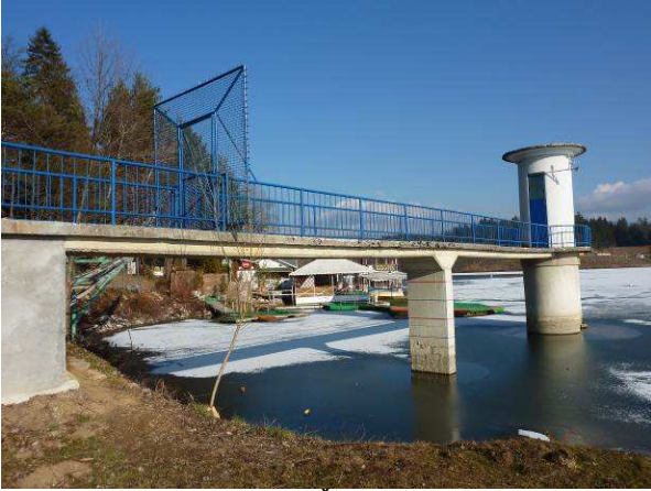
Slika 3: Pregrada Loče (Šmartinsko jezero); Vtočni objekt temeljnega izpusta in zajetja.
