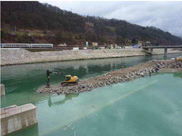
HE Krško: Odstranjevanje miniranih ostankov zaščitnega vodnjaškega zidu (januar 2012).
