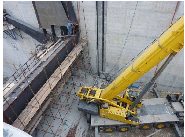
HE Krško: Montaža segmentne zapornice v 5. prelivnem polju (november 2011).
