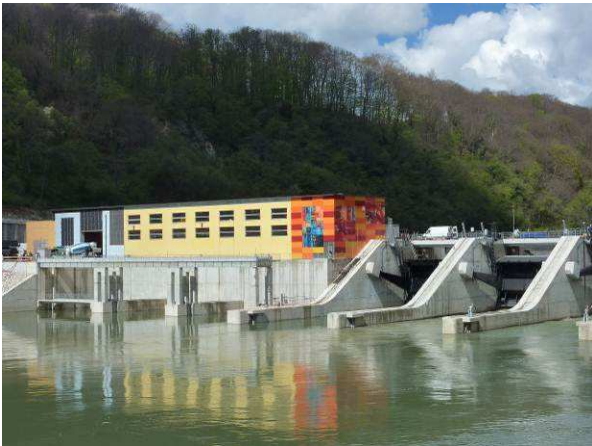
HE Krško v zaključni fazi izgradnje jezovne zgradbe.
