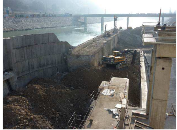
HE Krško: Začetek odstranjevanja zaščit druge gradbene jame. V osrednjem delu slike je vodnjaški zid, na levi straničasna ločna pregrada in v desnem spodnjem delu šesti stebel prelivnih polj ter nosilci žerjavne proge sifonskih zapornic (december 2011).
