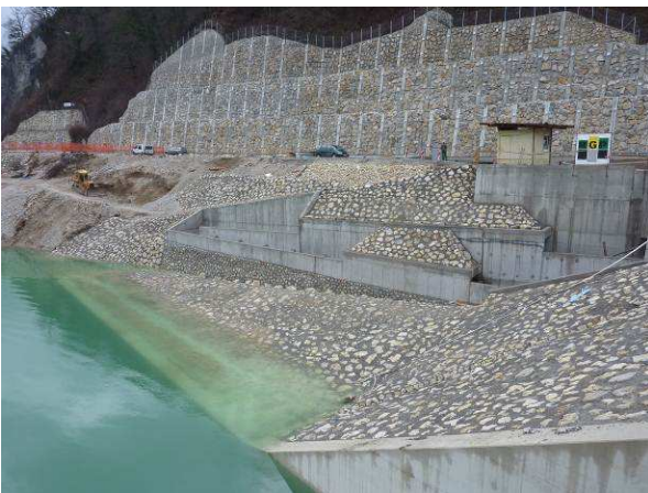
HE Krško: Prehod za vodne organizme in podporna stena nad cesto G1-5 na desnem bregu.
