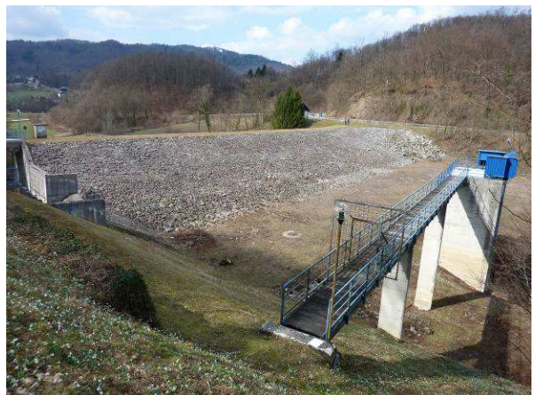
Slika 6: Pregrada in vtočni objekt Vonarje (Sotelsko jezero).
