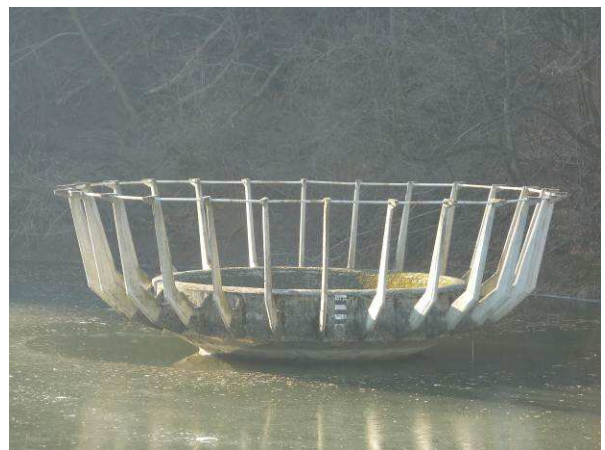
Slika 2: Pregrada Tratna (Slivniško jezero): Vtok v jaškasti visokovodni preliv.
