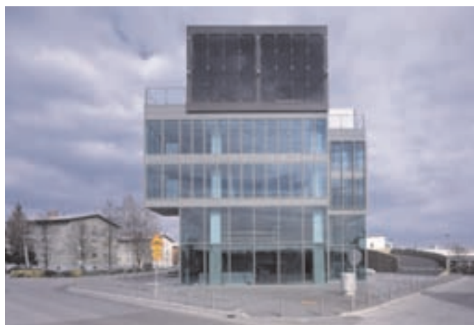
Slika 8: Pogled z zahodne strani. V pogledu / prerezu je poudarjena artikulacija stavbnih mas. (foto Miran Kambič) Western view. The view / section emphasises the building's articulation of masses.
