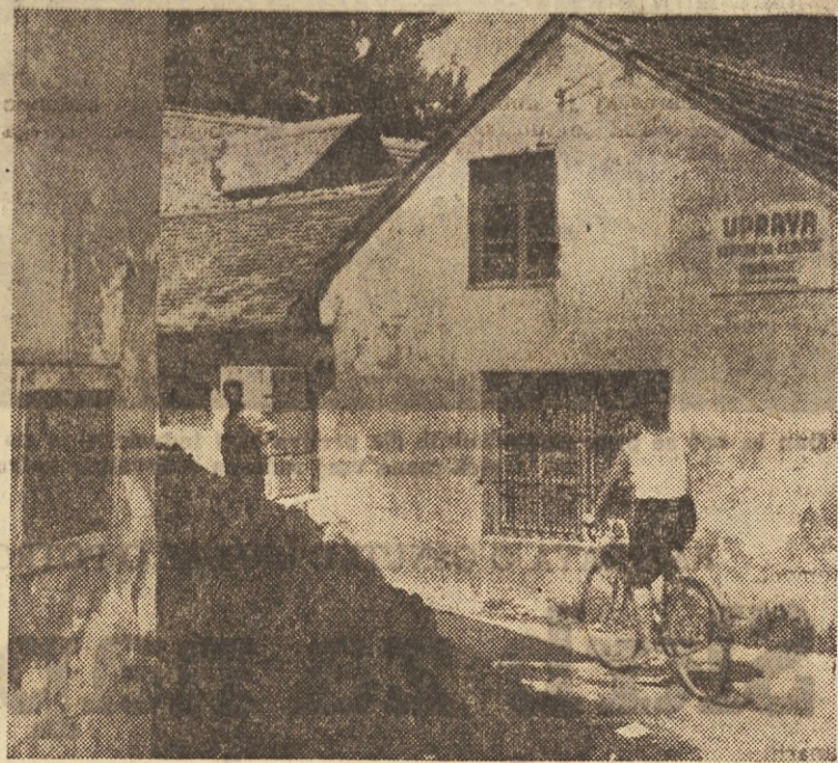
Stočlanski kolektiv Keramike iz Kamnika živi in dela v povsem neprimernih in razpadajočih poslopih. Njegova največja želja je zgraditi novo tovarniško poslopje
