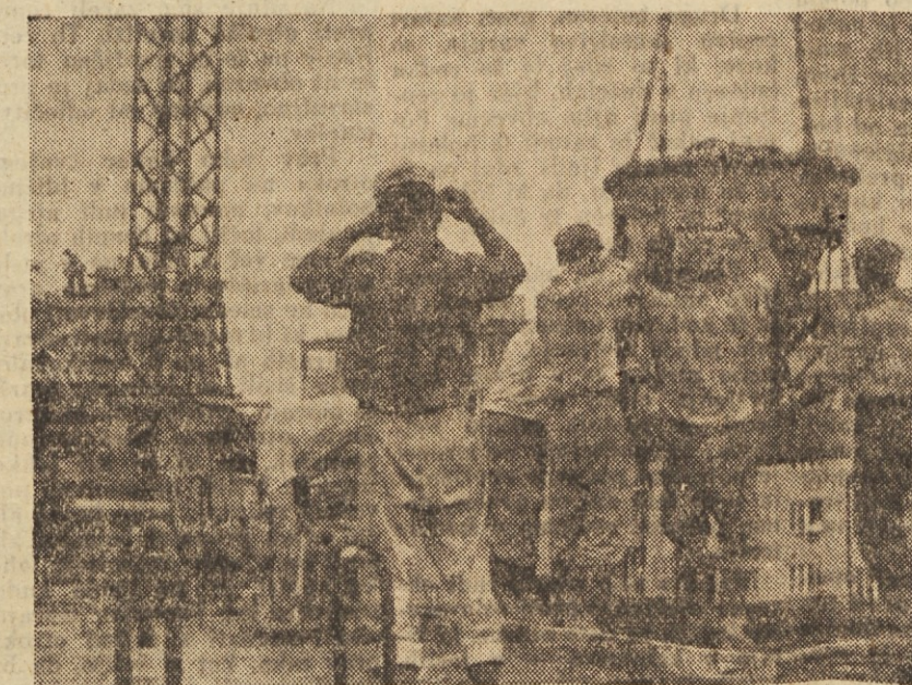
Mehanizacija je desna roka gradbenic. Nekajkratni glasni »horuk« in betonska injekcija se spremeni v prožen nosilni stebel
