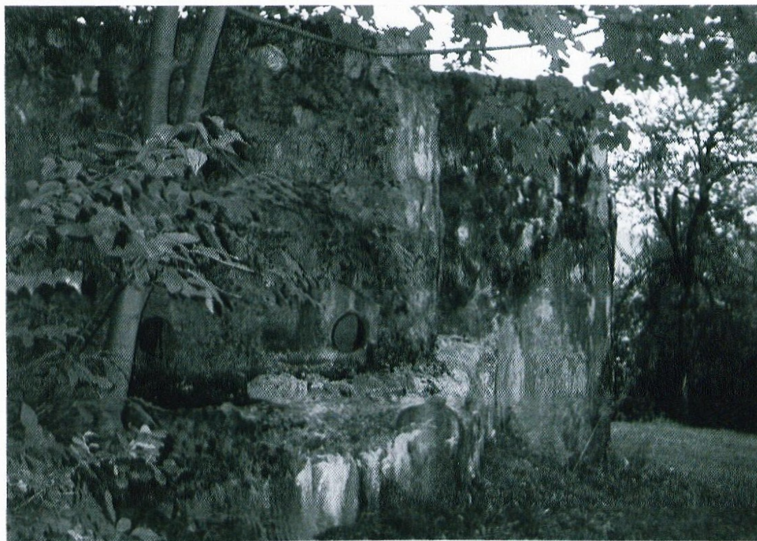
Čelna stran dvojnega strojničnega bunkerja ob cesti na Hlavče Njive; gre za eno atraktivnejših utrdb, hkrati najlažje dostopno, saj stoji tik ob cesti
