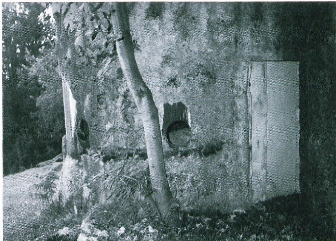
Zadnja stran strojničnega bunkerja na Hlavčih Njivah, z vhodom
