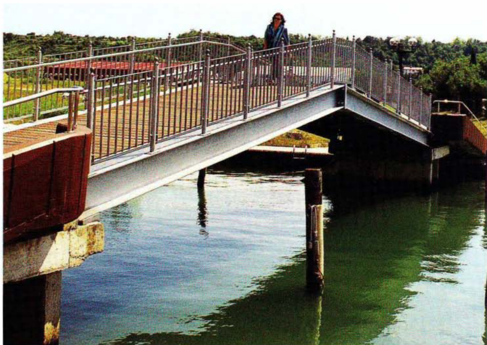
Brv v obliki strehe v Portorožu je trdnjša in manj ovira plovbo po kanalu.
