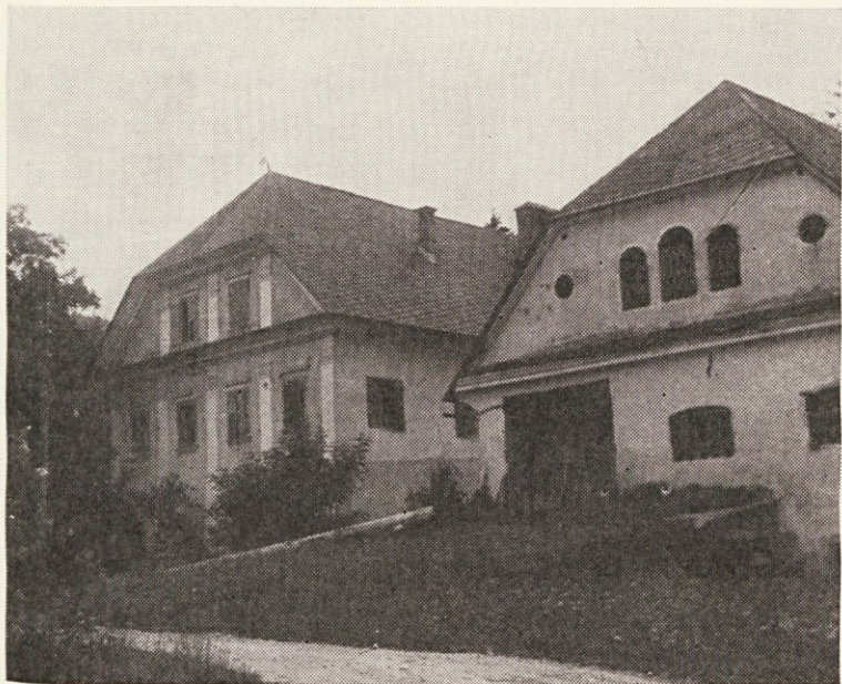
Sl. 3. Tavčarjev dvorec na Visokem sodi med najbolj reprezentativne kmečke arhitekture pri nas. Domačija nosi v zidovih in tudi v arhitekturnem dekorju sledove različnih gradbenih faz in prezidav od začetka 17. stoletja do sredine 19. stoletja. Mogočni oboki v pritličju in štukirano okrasje, ki obroblja slikarijo v teh prostorih, govore, da je šlo za mogočno domačijo že v 17. stoletju.
