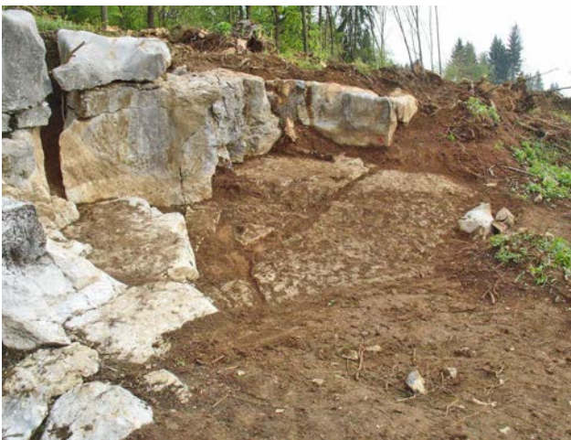
100 Situacija po očiščenju kamnoloma (pogled proti vzhodu).
