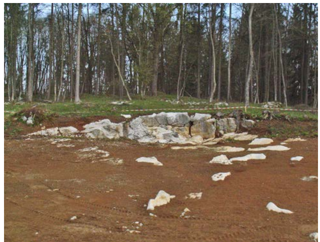
103 Situacija po očiščenju kamnoloma (pogled proti severu).
