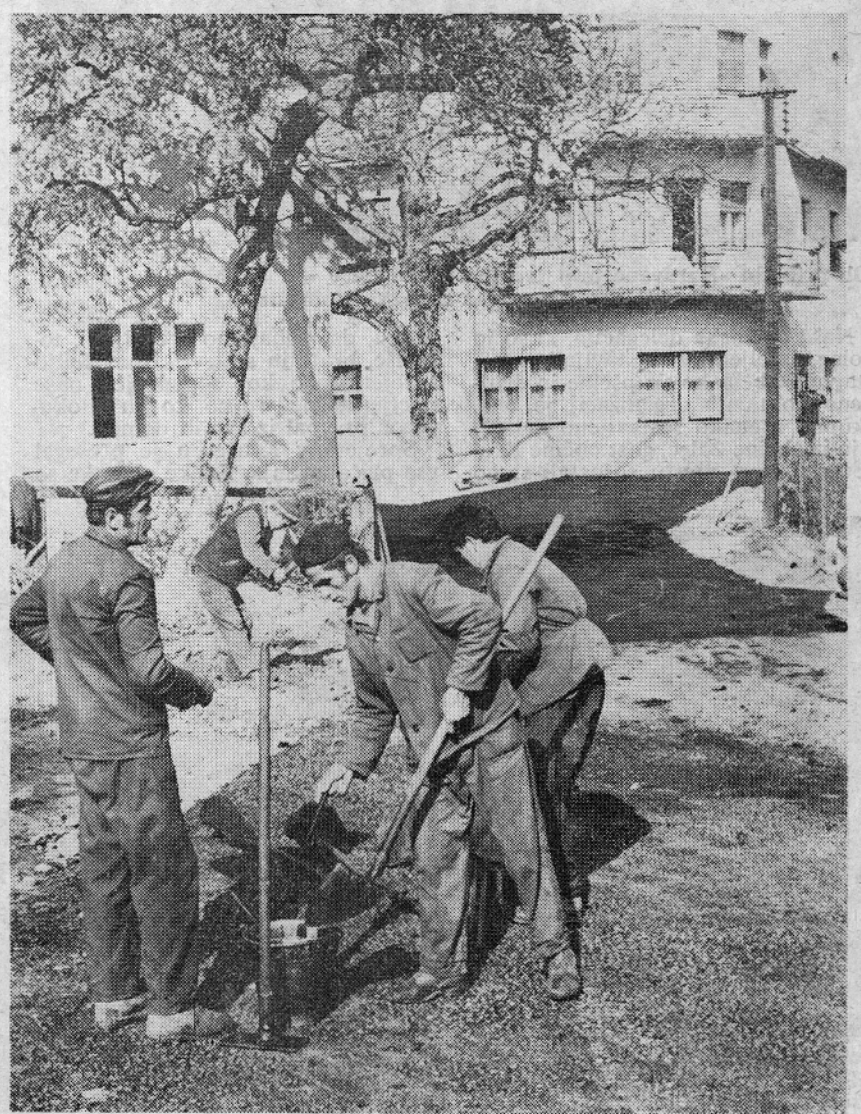
Podoba Ljubnega ob Savinji se je v teh dneh močno spremenila. Večino krajevnih cest so modernizirali, nanje so položili asfaltni trak v vrednosti preko dvajset milijonov starih dinarjev
