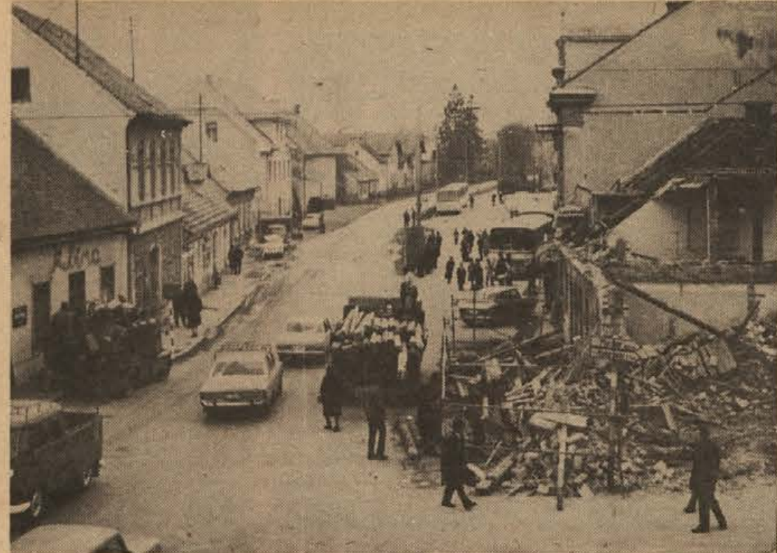
Pritlično vogalno stanovanjsko hišo na Trgu dr. Ivana Ribarja v Brežicah so te dni izravnali z zemljo. Na njenem mestu bo zrasla sodobna trgovina ljubljanske Elektrotehne. Stanovalci so se že pred meseci izselili v nova stanovanja oz. hiše, ki so jih dobili v zameno za porušeno poslopje. /Foto: Jožica Teppey/
