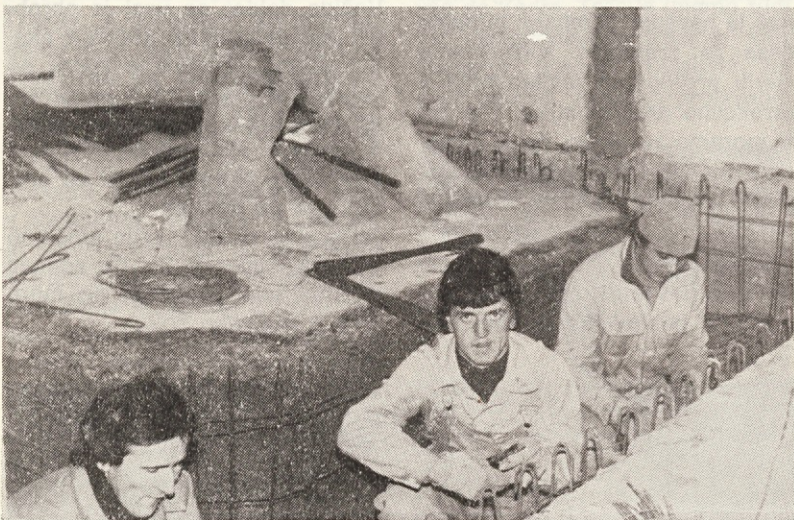
Delavci GP Pionir ob temeljih za elektronsko kontrolo
