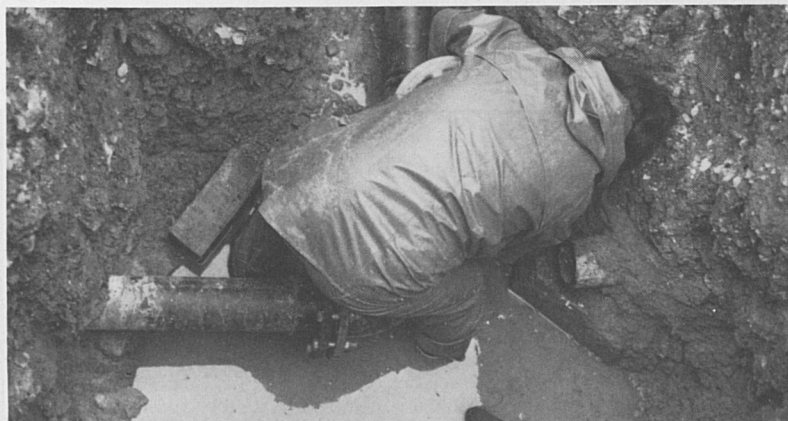
Priključitev na novo izdelanega vodovoda na novo linijo. »Pohiti Vojko, voda je že skoraj v škornjih«.
