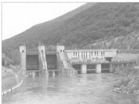
Hidroelektrarna Solkan, prva po drugi svetovni vojni zgrajena velika hidroelektrarna na reki Soči. Bila je prva daljinsko vodena elektrarna v takratni Jugoslaviji, obratovati je začela leta 1984
