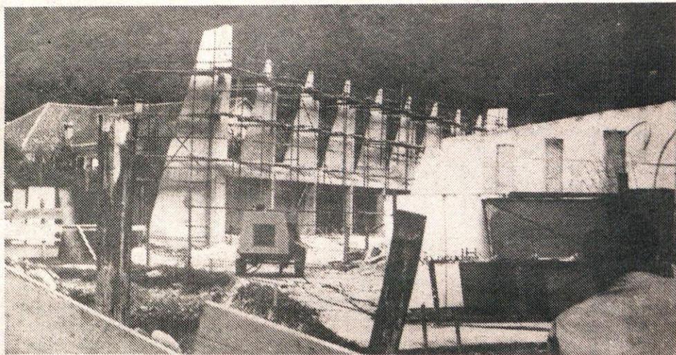
ŠPORTNA DVORANA ZA VSE – O takem objektu še nedavno tega niti sanjali nismo, že na jesen pa si bomo lahko v novi športni dvorani ob osnovni šoli Frana Albrehta ogledovali zanimiva športna srečanja, se rekreirali po napornem delovnem dnevu ali si v njej ogledali tudi najrazličnejše prireditve
