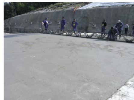
Slika 8 • Zaščita desne brežine pokritega vkopa z začasnimi geotehničnimi sidri in z armiranim brizganim betonom
