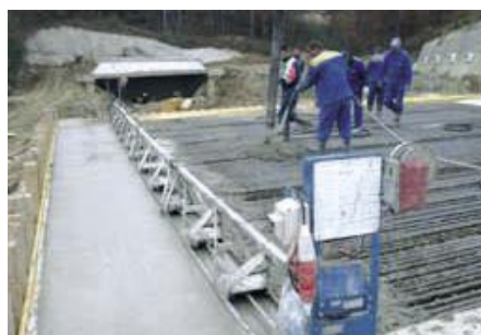
Slika 1 • Navezava pokritega vkopa Cenkova na predor – betoniranje krovne plošče pokritega vkopa
