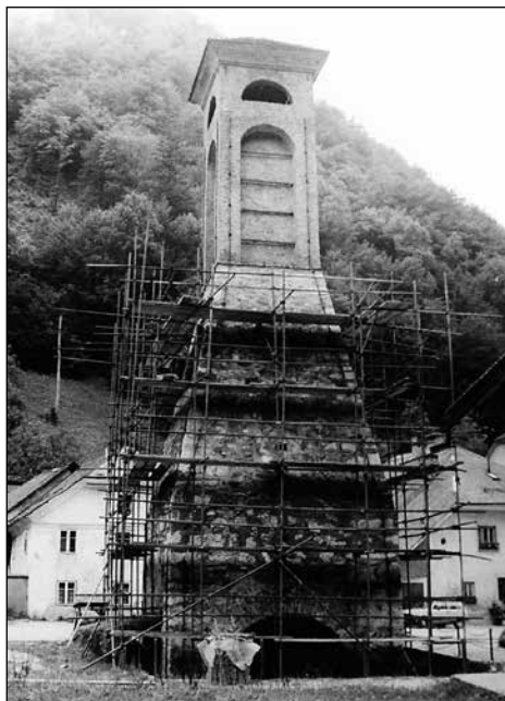
Sanacija plavža 1980–81. Foto: arhiv Muzeja Železniki
