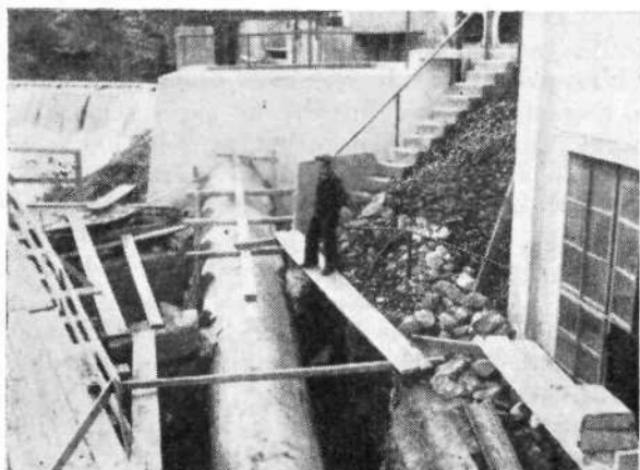
Gradnja elektrarne V skalcah. Na sliki dovodni rov za malo turbino
