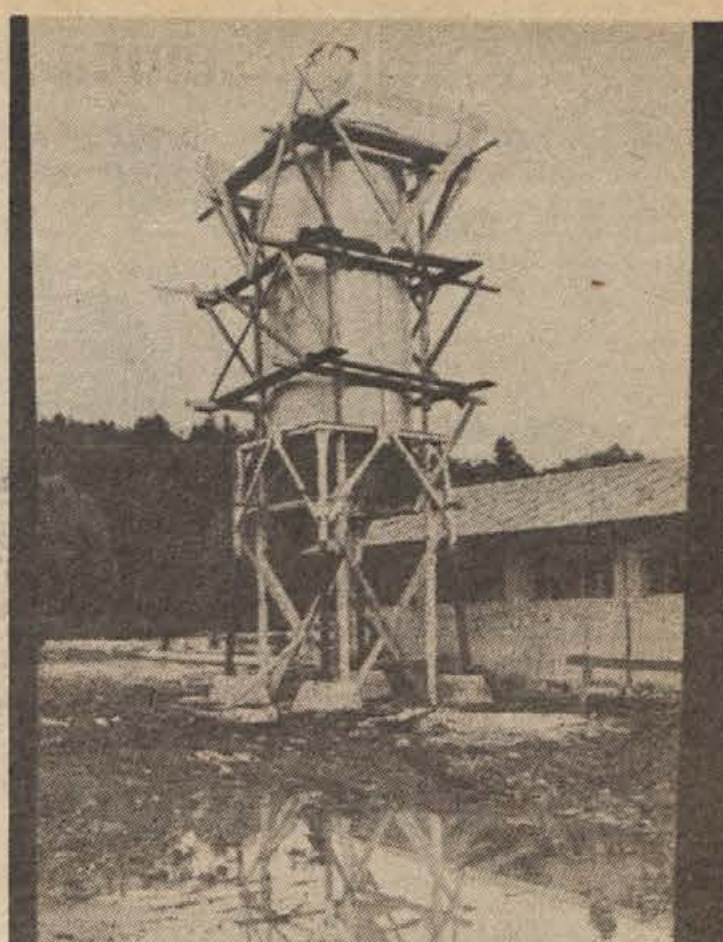
Na žagi novomeškega Gozdnega gospodarstva v Pogancih pri Novem mestu so te dni postavili nov silos za žaganje (na sliki). Prej so žaganje iz zasilnega skladišča na vozila nalagali s koši, zdaj pa je postopek povsem mehaniziran in enostaven (Foto: S. Dokl)
