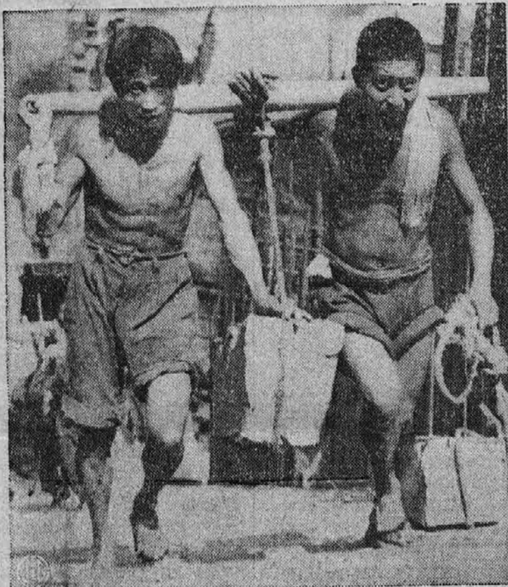
Pozidava glavnega mesta Kitajske — Chungking je jako naporno delo, kajti ves material morajo prenesti od obvežja reke na rokah daleč gori v mesto. Trukov nimajo dovolj na razpolago za prevažanje, zato to delo vrše moží, kot nam kaže gornja slika.
