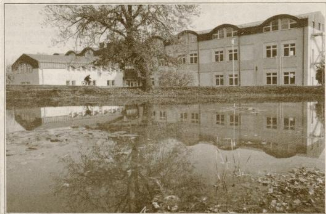
Nadgradnja in prenova šole v Ljudskem vrtu sta končani. V naslednjih dneh čaka bližnjo okolico še ureditev kanalizacije, čez dve leti pa po vsej verjetnosti gradnja prizidka in nove telovadnice.
