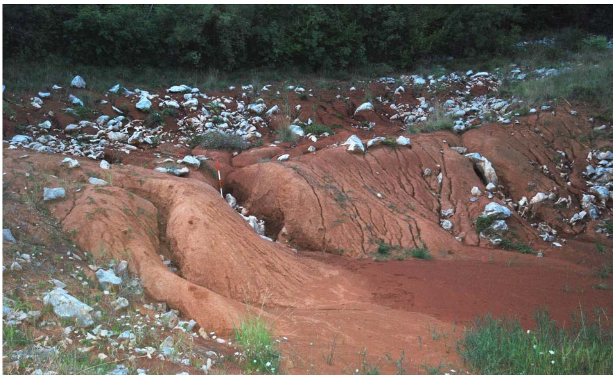
Slika 13 Učinki vodne erozije na robovih izkopa za zemljo. Arber, vrtača št. 37.
