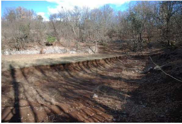
Slika 225 Izkop v vrtači št. 52, pogled proti vzhodu.
