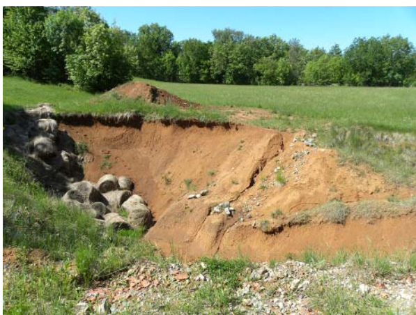
Slika 161 Izkop v vrtači št. 25. Pogled proti jugozahodu.
