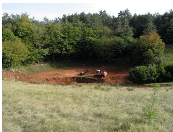
Slika 3 Izkop zemlje v vrtači pri Dobravljah.
