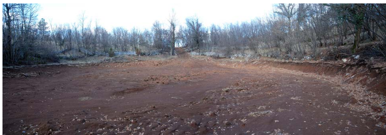
Slika 220 Izkop v vrtači št. 51, pogled proti severovzhodu.
