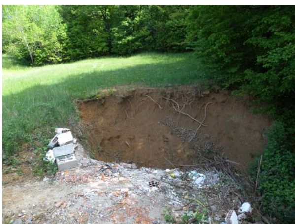
Slika 216 Vrtača št. 49, presek na severni strani izkopa.
