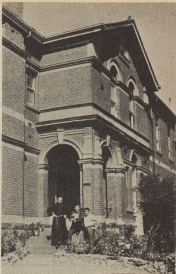
Melbourne: Glavni vhod v Baragov dom
