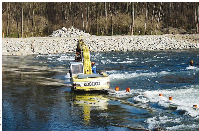
Pilotiranje z desnega brega proti sredini reke ter sprotne gradnje drče
