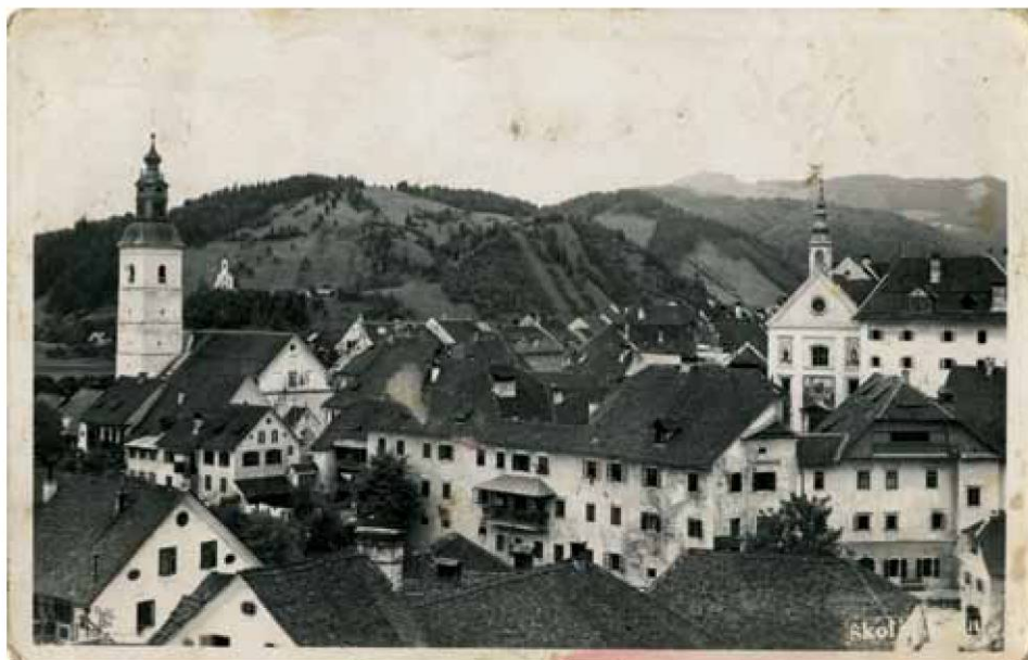
Pogled na hiše v nekdanjem predmestju Pred selškimi vrati in hiše na desnem bregu Selške Sore. V sredini poslopje nekdanje Kasarne/Jesharne, levo podrta Birollova hiša, desno Funtkova hiša. (razglednica v zasebni lasti)
