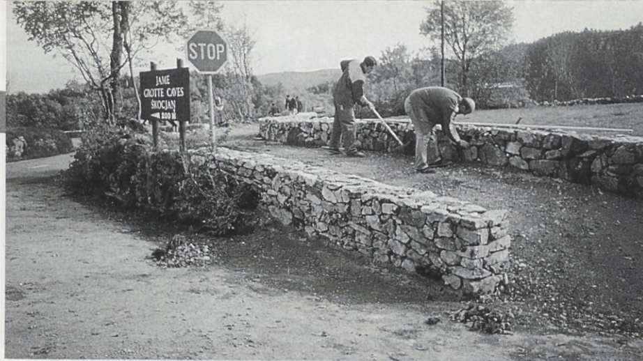
Delavci SGP Kraški zidar urejajo površine za turistično pot
