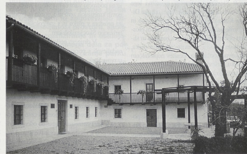
Upravna zgradba javnega zavoda Park Škocjanske jame, Slovenija, Škocjan št. 2.
