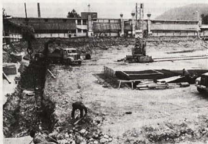
Priprave na gradnjo nove proizvodne hale (B I) za smuč
