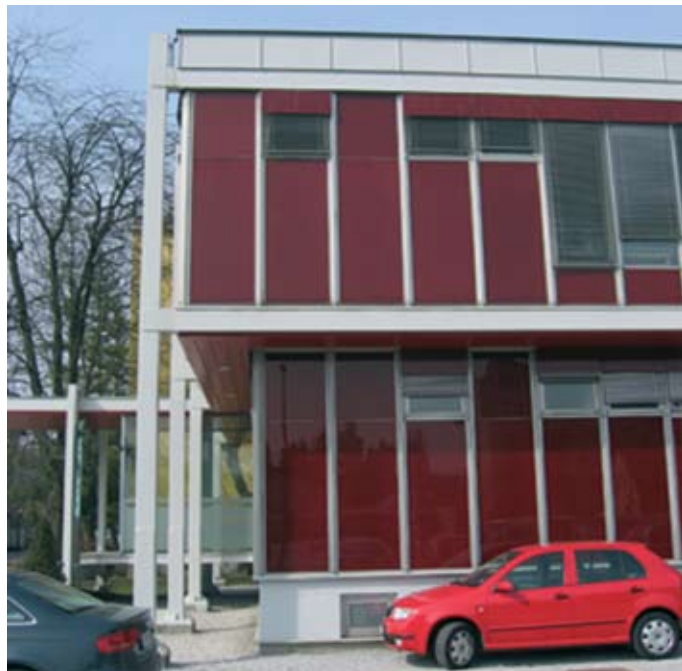
Slika 6: Miloš Lapajne: jasno vidna jeklena konstrukcija Narta studia tovarne Ilirija v Ljubljani.
