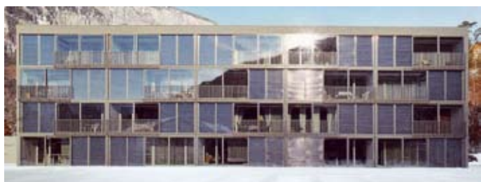
Slika 2: Gradivo s fazno preobrazbo je vgrajeno v zasteklitev fasade in pripomore k boljši energijski učinkovitosti stavbe in videzu fasade, ki glede na fazno stanje gradiva spreminja stopnjo prosojnosti [Ritter, 2007: 171].
