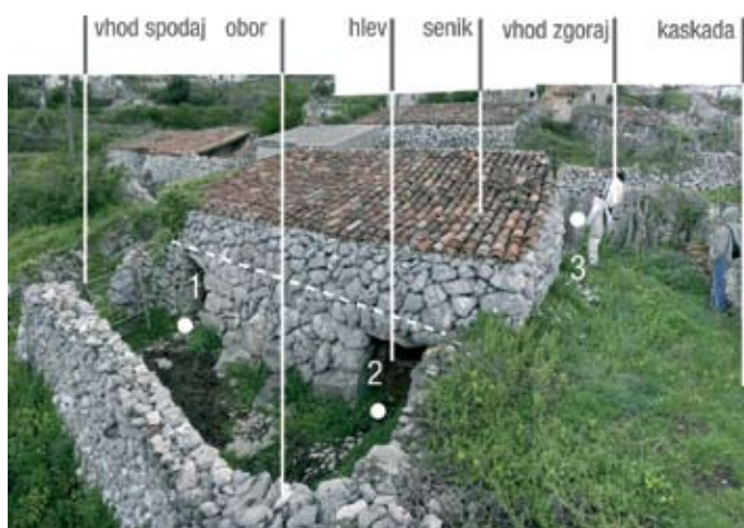
Slika 5: Obor z objektom in shema funkcionalne izrabe. Spodaj je hlev, zgoraj je senik v kombinaciji z orodiščem. Hlev je dvoceličen, ima dva vstopa (oznaka 1 in 2); delitev prostora v hlevu je izvedena s prepletom šibja. Zgornja etaža je enocelična z vstopom označenim s številko 3. Na fotografiji se dobro opazi enovitost naklonov strešin objektov, ki so skoraj vzporedne s padajočim terenom.
