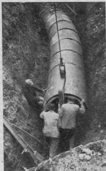
Gradnja zbirnega kanala \phi 140 cm
