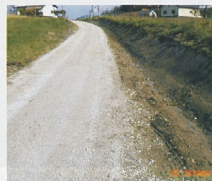
Sanacija ceste in ureditev odvodnjanja na cesti v spodnjem Podlehniku
