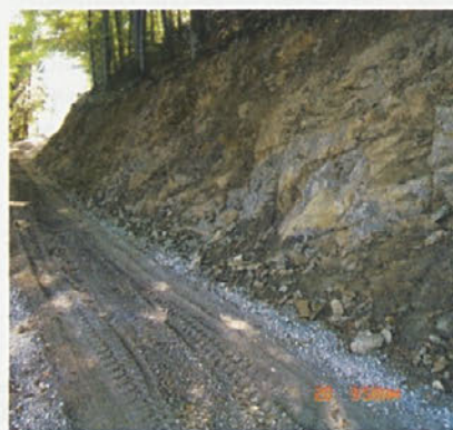
Sanacija ceste na območju Ložin
