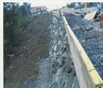
Sanacija plazu na cesti Stanošina-Pestike-Sedlašek
