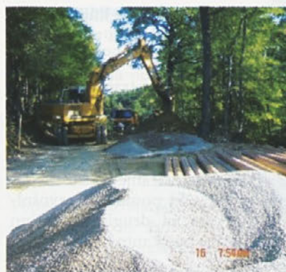
Izvajanje gradbenih del v septembru
