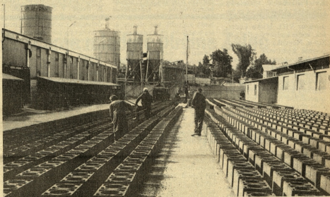
Pogled na proizvodnjo Schiedel dimnikov
