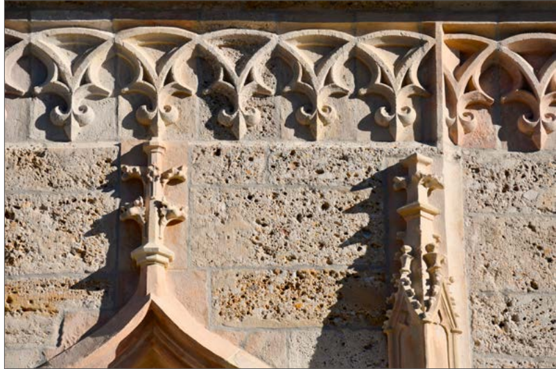
4. Fiale na vhodnem portalu v Kranju, slepi trilist iz peščenjaka in konglomerat drobnejše strukture v nivoju fasade (© ZVKDS, foto: Matevž Remškar)
