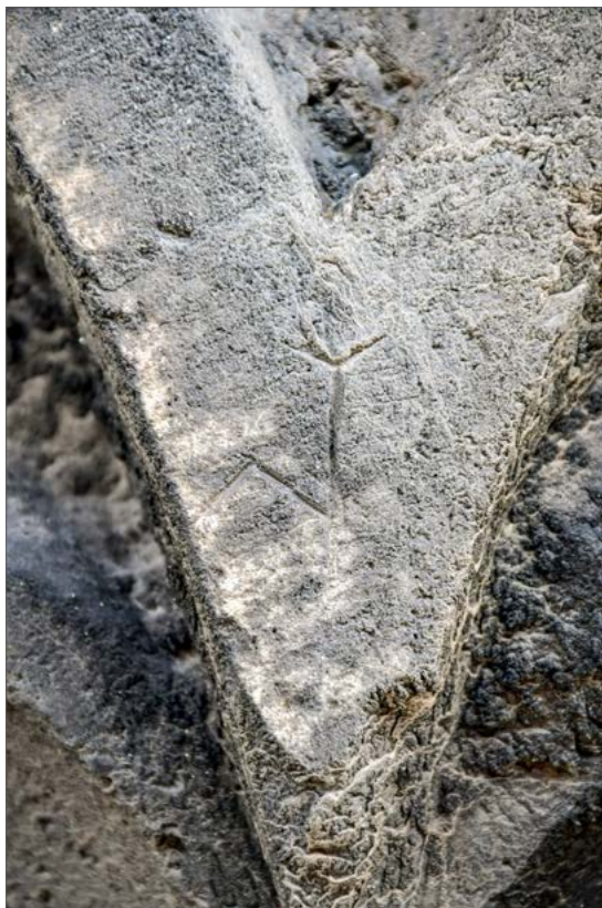
7. Znak na zvoniku v Kranju, ki pripada kamnoseku iz stavbarske delavnice cerkve sv. Brijuni v Naklu pri Divači (© ZVKDS, foto: Matevž Remškar)
