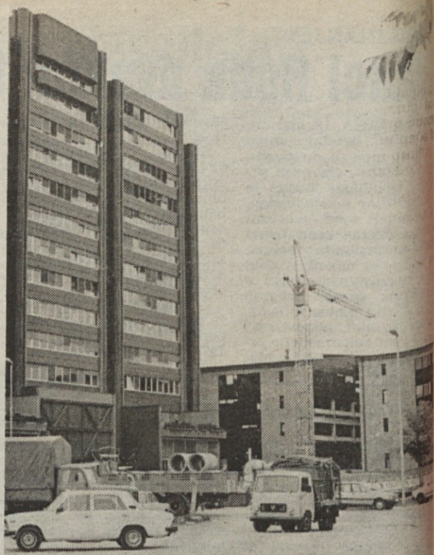
Začetek gradnje prizidka Emonke na Šmartinski
