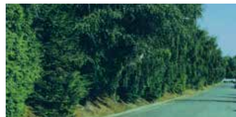
Slika 8: Obrasel zemeljski nasip
