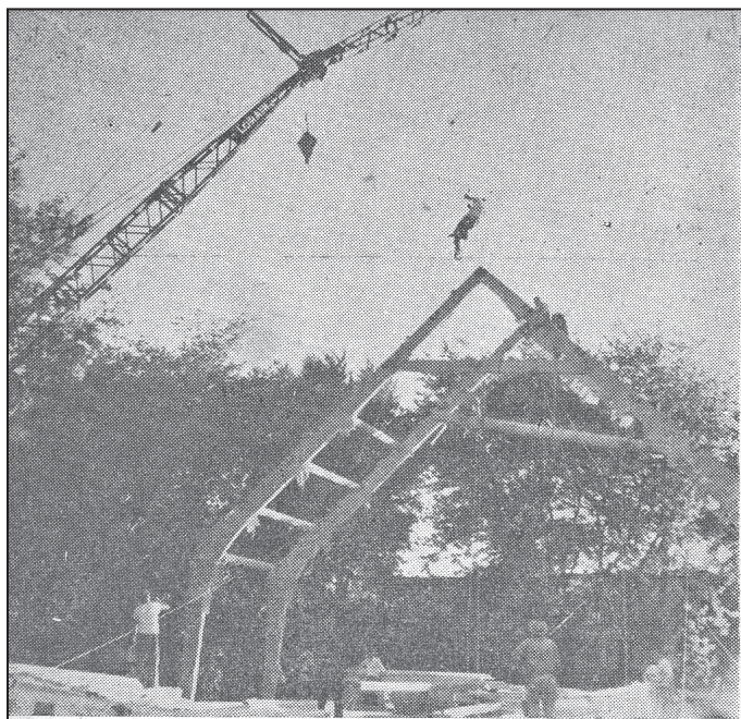
Postavljanje ogrodja za slovensko cerkev v Torontu -1953
