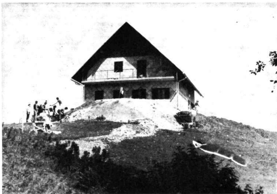
Nova planinska koča na Blegošu med gradnjo
