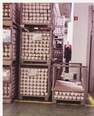
Založena APZ - nedostopni gasilniki in hidrant
