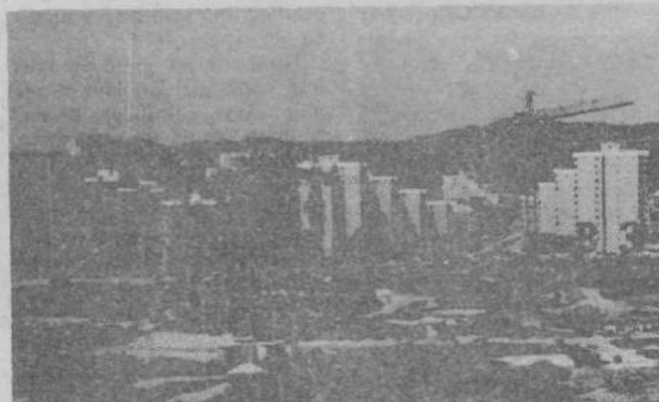
Pogled na gradbišče Imosa v juliju 1982.
