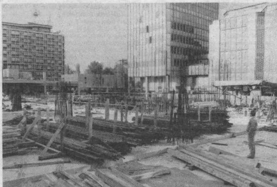
Nova Modna hiša bo še enkrat večja od sedanje blagovnice. Prav te dni so gradbinci po treh podzemnih nadstropjih prešli koto »nič« in pričeli graditi pritličje. Polovico denarja so že zbrali, nadaljnjih 90 milijonov dinarjev morajo imeti zagotovljenih do marca 1984. Del sredstev bo dala temeljna organizacija, preostali del pa sponzorji. V novo, dvonadstropno blagovnico naj bi se preselili leta 1985.
