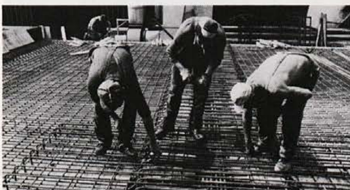
Vezanje armaturne plošče pri novogradnji – za dovozno rampo
