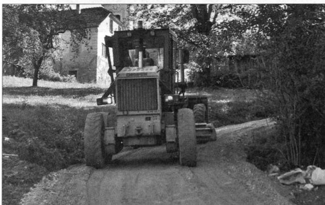
Graditev ceste na strmini je bila zahtevna, a uspešno izpeljana
