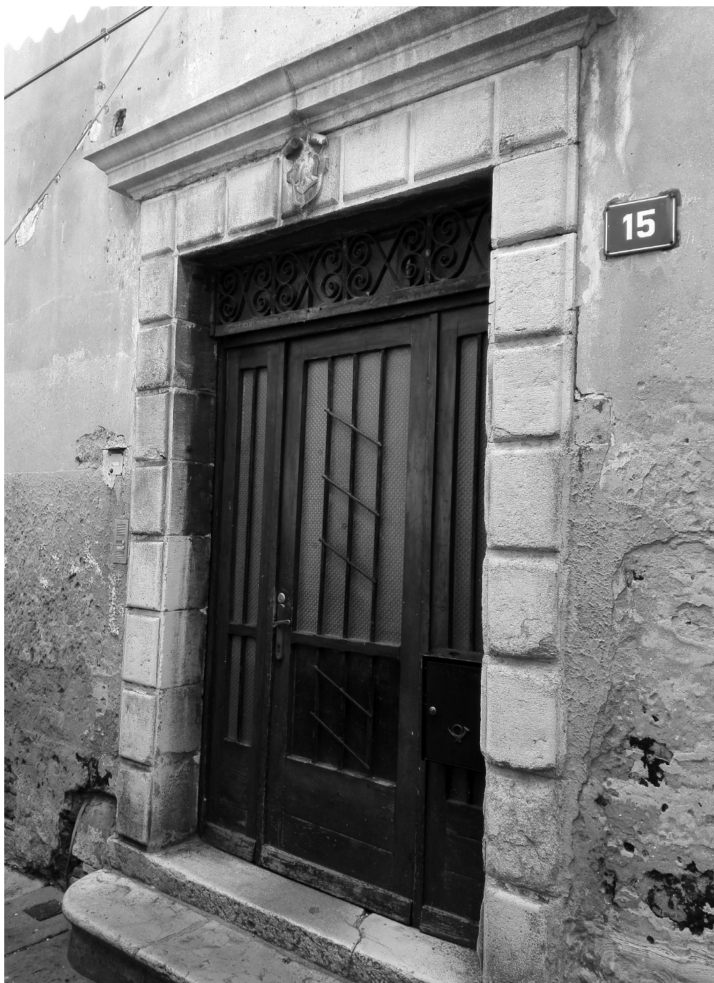
2. Vhodni portal hiše Barbabianca (Čevljarska ulica 15)
