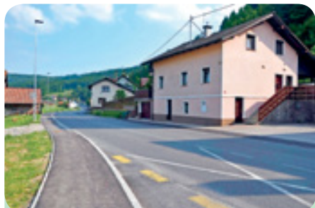
Izgradnji 1. faze pločnika je sledila izgradnja 2. faze, v dolžini 443 m, vse do centra Velike Račne, kjer se je nov pločnik povezal z obstoječim pločnikom. Hkrati smo uredili tudi cestno razsvetlavo ter obnovili vozišče. Slovesnost po končanih delih je potekala 5. junija 2019.
