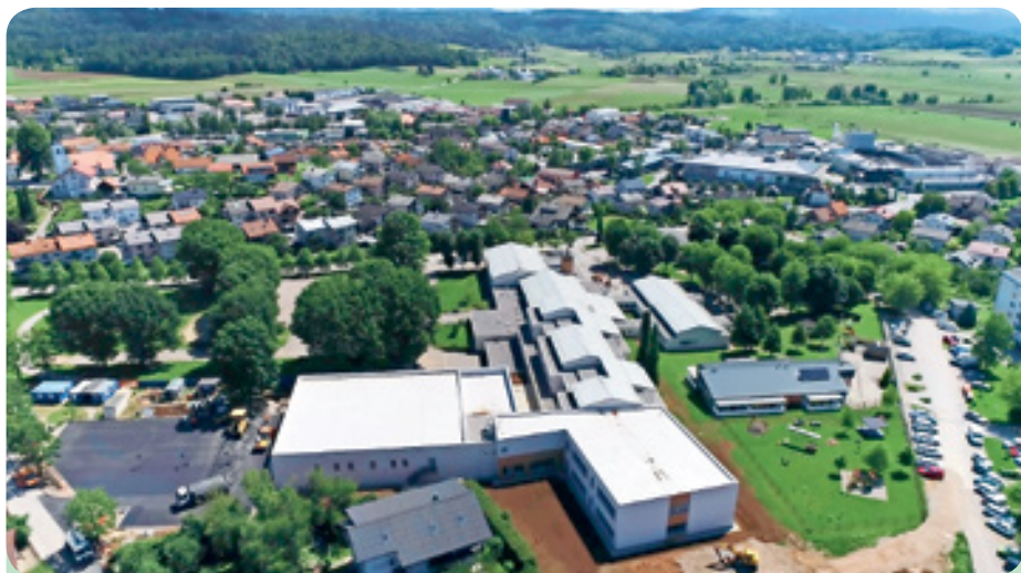
Gradnja prizidka in nove športne dvorane k Osnovni šoli Louisa Adamiča Grosuplje je že v zaključni fazi.
