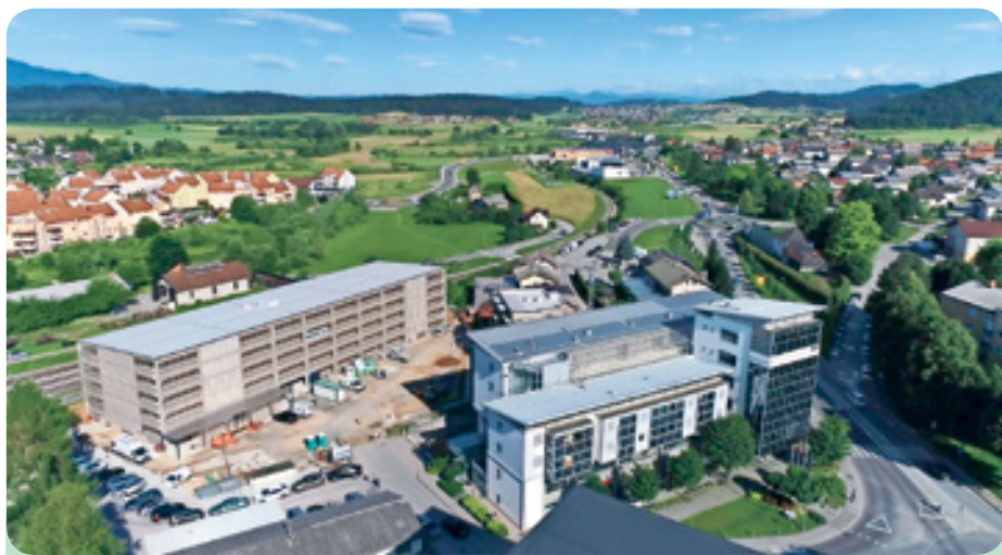
Gradnja parkirne hiše P+R Grosuplje je že v zaključni fazi.
