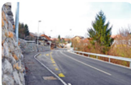
Med Šmarjem - Sapom in Malim Vrhom smo uredili pločnik v dolžini 806 m, razširili vozišče s 5,5 na 6 m, uredili prehode za pešce in avtobusna postajališča. Postavili smo novo cestno razsvetlavo in uredili odvodnjavanje. Nove pridobitve v Šmarju - Sapu smo slovesno predali svojemu namenu 19. decembra 2017.
