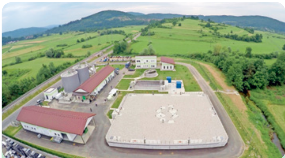
Čistilna naprava Grosuplje lahko dnevno prečisti do 7.700 m 3 odpadne vode, kar zadostuje populaciji do 20.000 prebivalcev. Očiščena odpadna voda pa odteka v potok Bičje.
