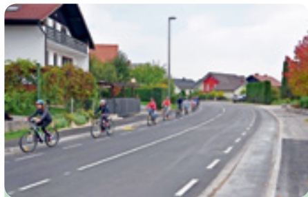
Prenovljeno Župančičevo cesto v Grosupljem smo slovesno predali svojemu namenu 5. oktobra 2017. V sklopu rekonstrukcije Župančičeve ceste smo uredili tudi vozni pas za kolesarje.
