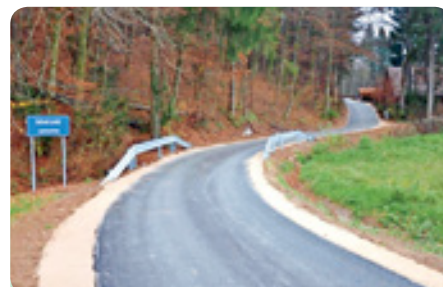
Novo povezovalno cesto Spodnje Blato-Gatina smo na Spodnjem Blatu slovesno predali v uporabo 13. novembra 2018. Asfaltirali smo še manjkajočih 240 m ceste, ob Gatinskem potoku, ki je dobil tudi svojo označevalno tablo, pa smo postavili tudi ograjo.
