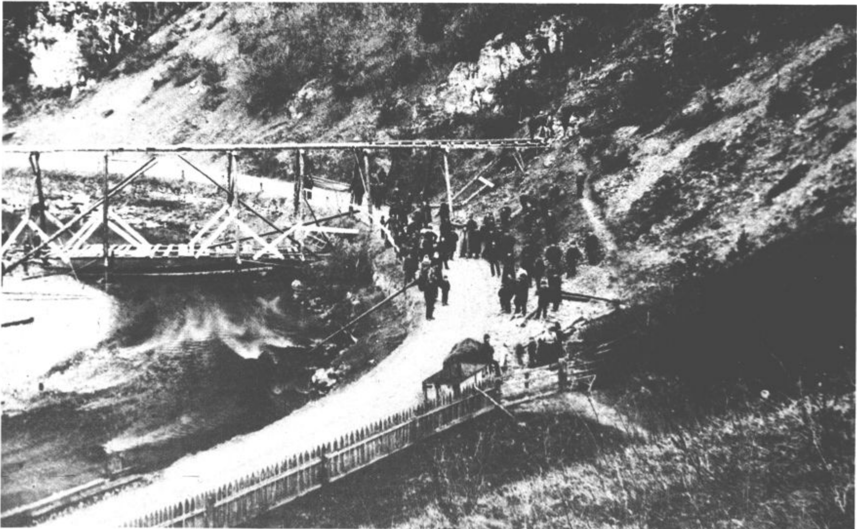
Začetek gradnje prvega dela železniške proge Celje—Velenje (predor Penk) — 22. 12. 1888
