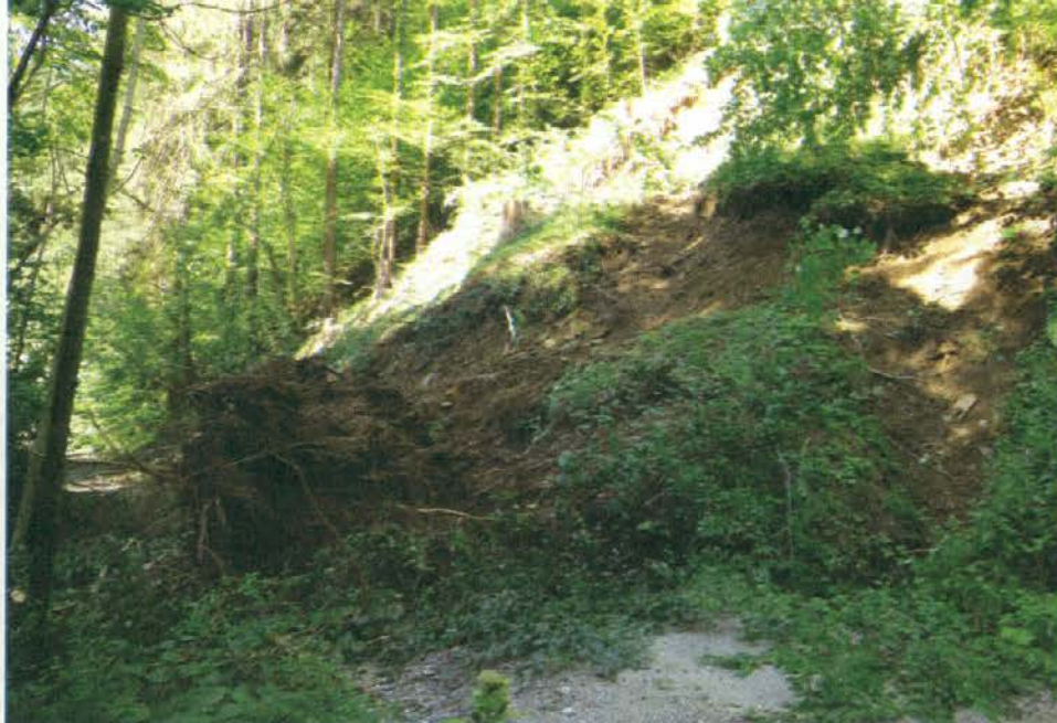
Zemeljski plaz na gozdni cesti v Radeljskem jarku (8. 8. 2014)
