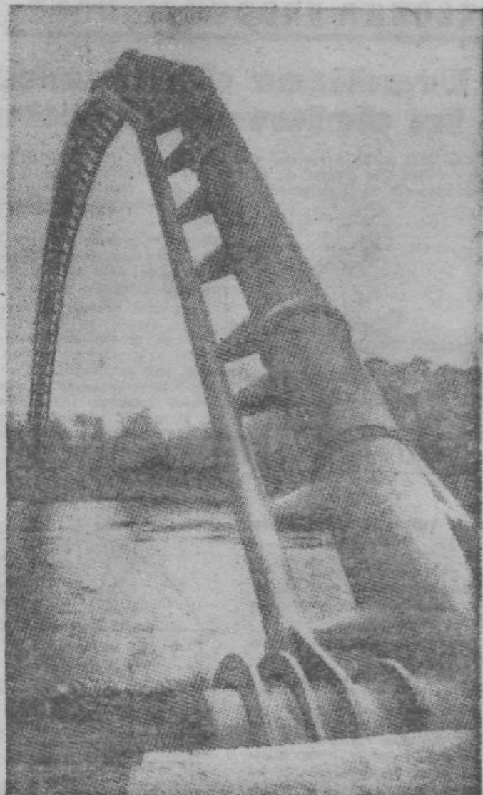
Slika kaže prosti plinovod, s katerim vodijo plin na velike razdalje
