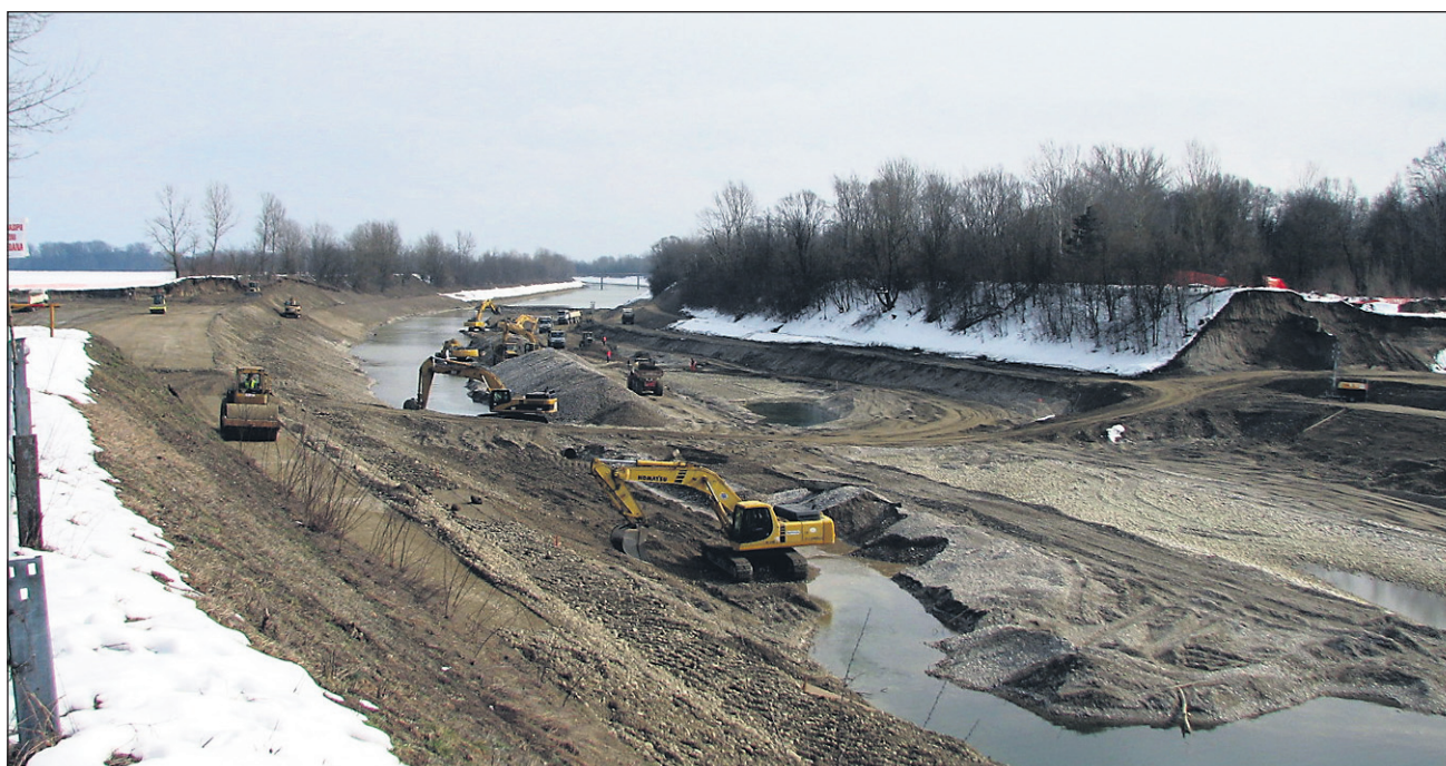
Sanacijska dela na HE Formin in na nizvodnem kanalu so v teku (na posnetku) in naj bi bila končana do sredine marca. Vendar, kot opozarja vodstvo DEM, mora ministrstvo prenehati blokirati sodelovanje s Hrvaško, saj je treba sanirati še pretrgane nasipe na hrvaškem katastrskem območju, sicer ne bo možno vzpostaviti normalnega delovanja HE Formin, kar pa je za preprečevanje poplav ob pričakovanem dvigu pretoka Drave spomladi nujno ...
