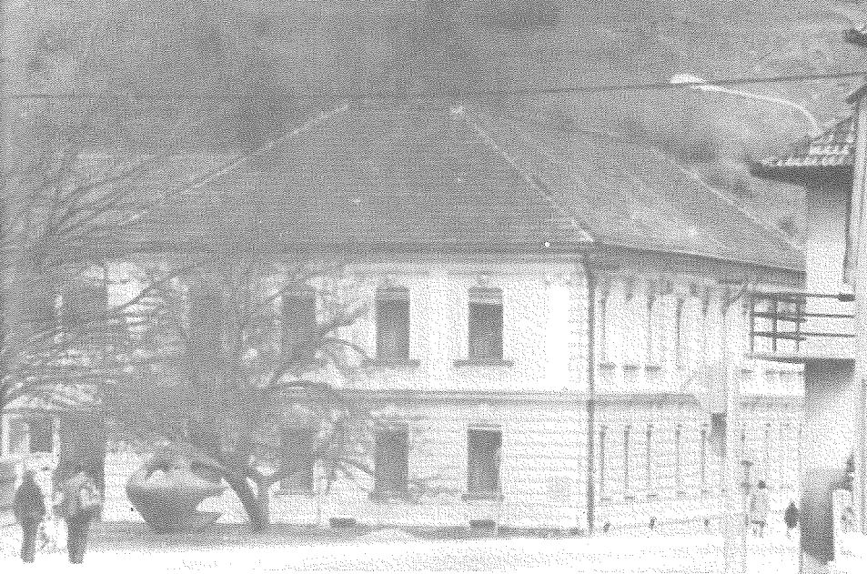
Zgradba Medobčinske geodetske uprave v Slovenj Gradcu
