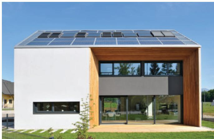
Slika 7: Hiša je v celoti zgrajena iz okolju prijaznih materialov, ki imajo največji vpliva na okolje v fazi izdelave. Hiša vključuje fotovoltaično elektrarno, sončne kolektorje za toplo vodo, strešna okna, zbiralnik deževnice za sanitarno vodo in zalivanje, ter pametne inštalacije.
